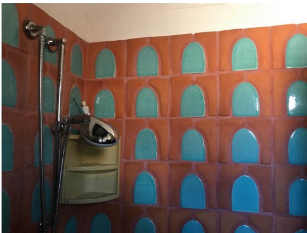
Foto n. 7 - Vista interna (Particolare rivestimento)
