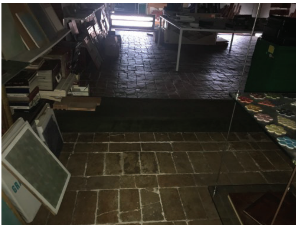
Foto n. 11 - Vista interna (Particolare pavimentazione)
