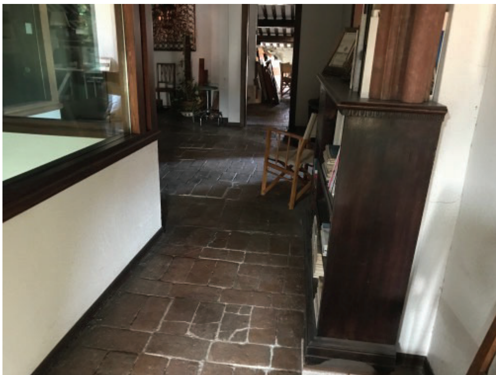
Foto n. 6 - Vista interna (Particolare pavimentazione)
