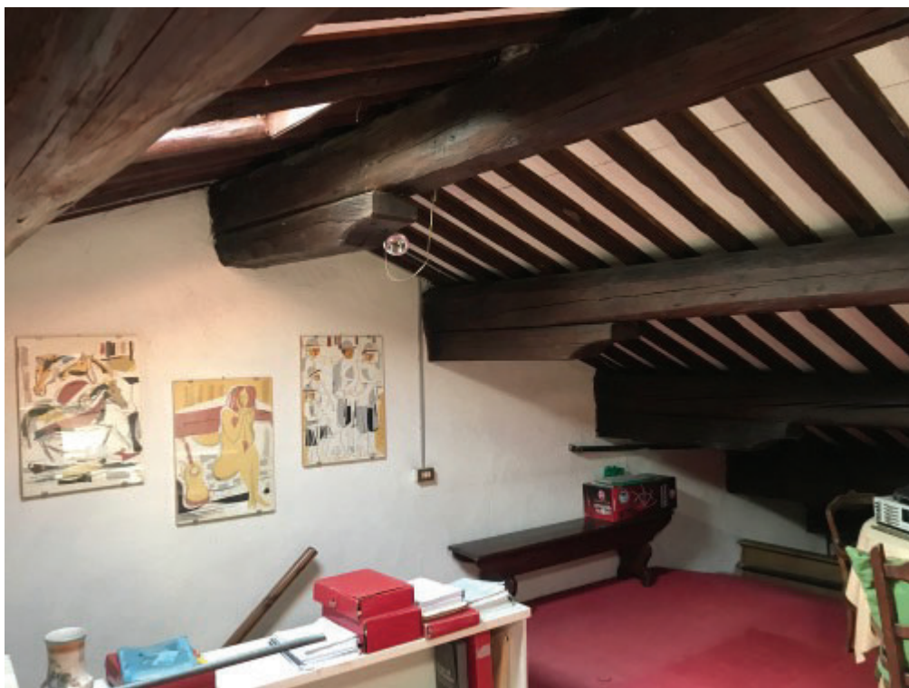
Foto n. 14 - Vista interna - Soppalco
