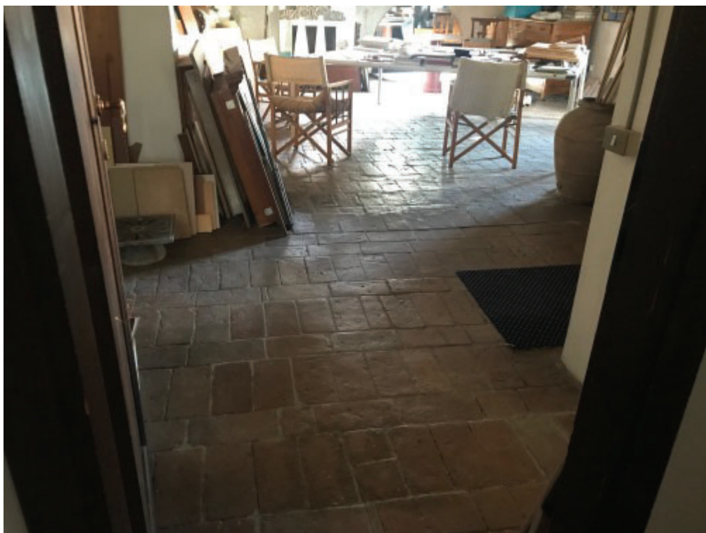
Foto n. 8 - Vista interna (Particolare pavimentazione)
