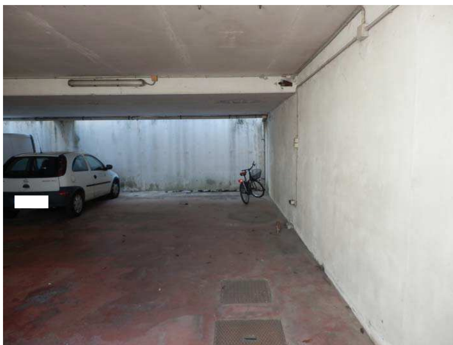
Foto 8 - Piano interrato – posto auto coperto
