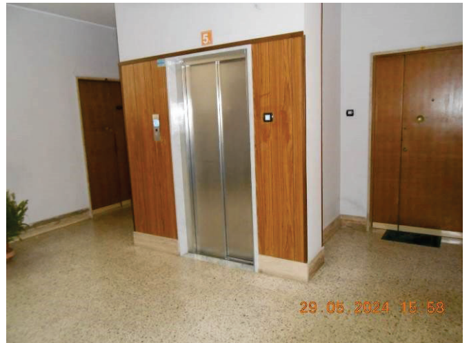
Vano Scala - Ascensore
