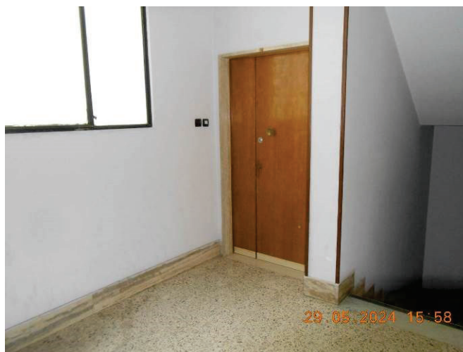
Vano Scala - Ingresso
