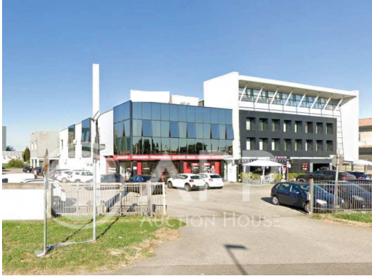
Foto 1 Prospetto da Via Rovigana
